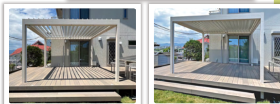
▲屋根の開閉で日差しを調節
